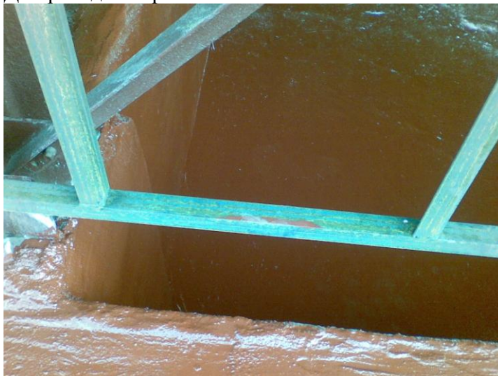
После проведения работ
