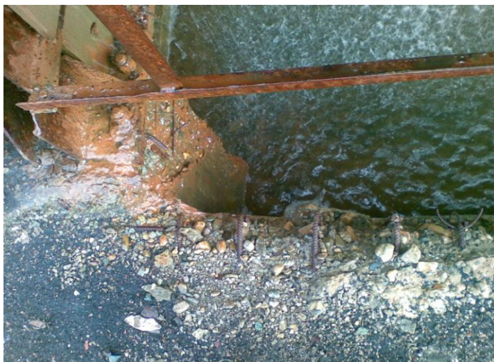
До проведения работ
