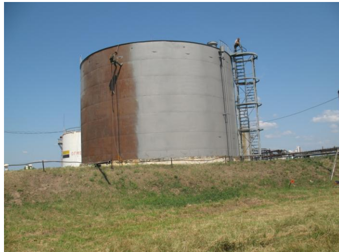
Нанесение цинксодержащей грунтовки
