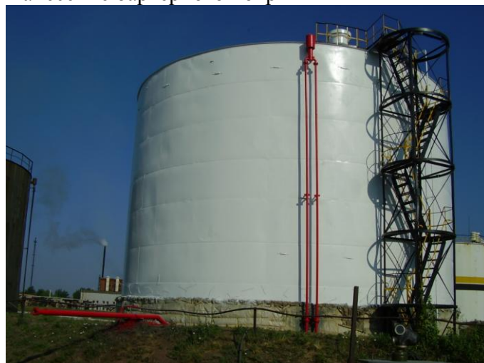
Нанесение финишного покрытия
