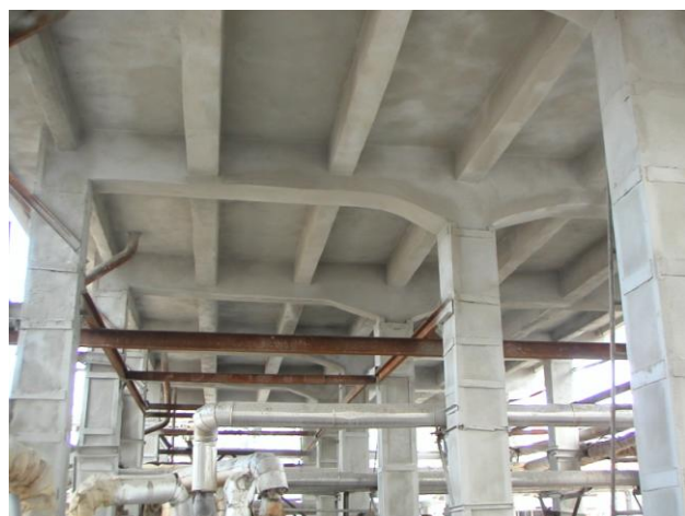
После проведения работ
